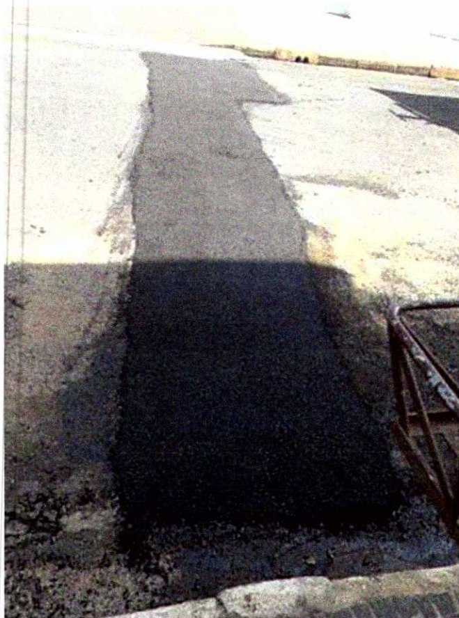
Imagem 1 - Pavimentação asfáltica na Rua Albina Alves, 44, Vila Santa Maria.
