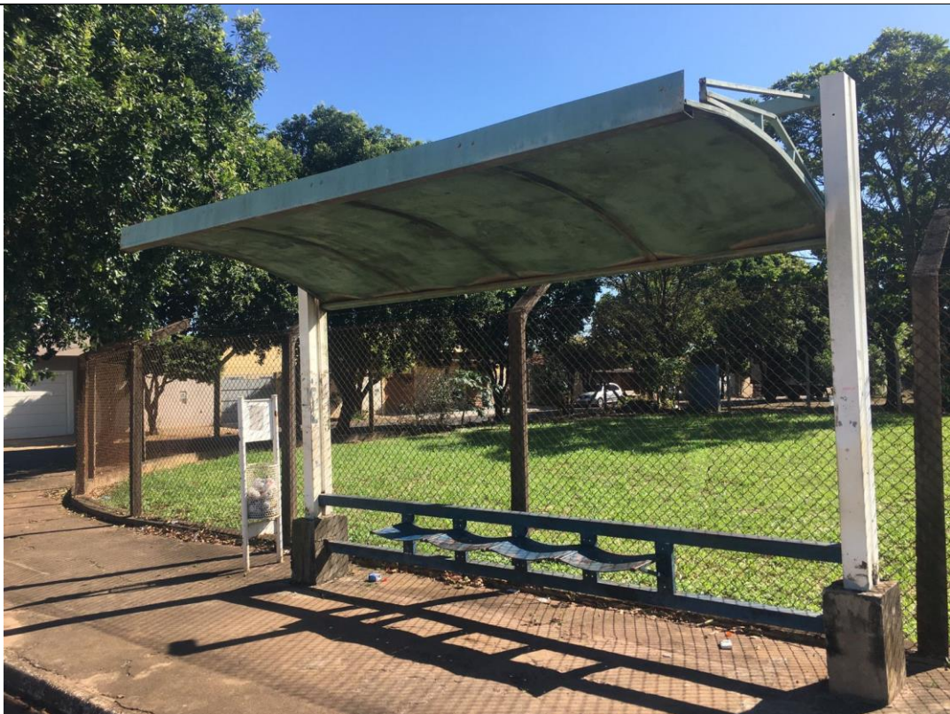
Rua Paulo Rippa (defronte caixa d'água)
